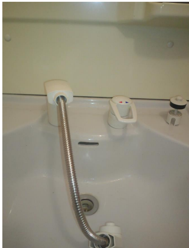
⑥洗面台のレバーハンドルを真ん中の位置で上に上げて、シャワーホースを下に下げ水を出します
