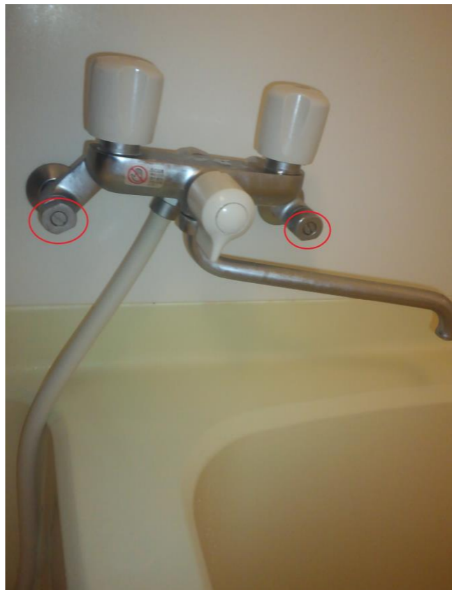
⑧UBの混合水栓です 水・お湯ハンドルを開けてシャワーホースを床に置き、赤丸印のネジを緩めます
